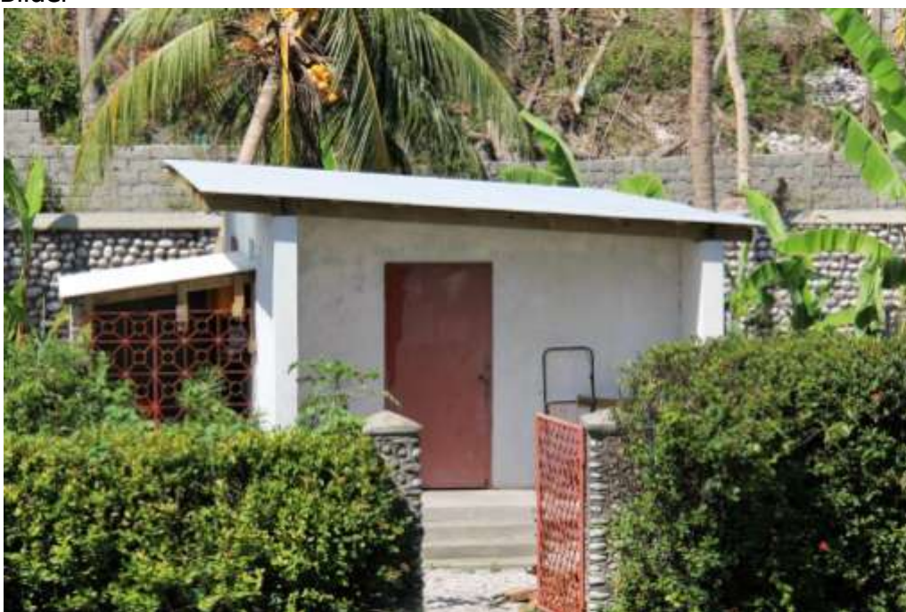
Abbildung 1: Das erste Dach ist fertig
