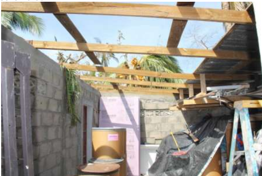
Abbildung 2: Dieses Dach wurde schon gemacht
