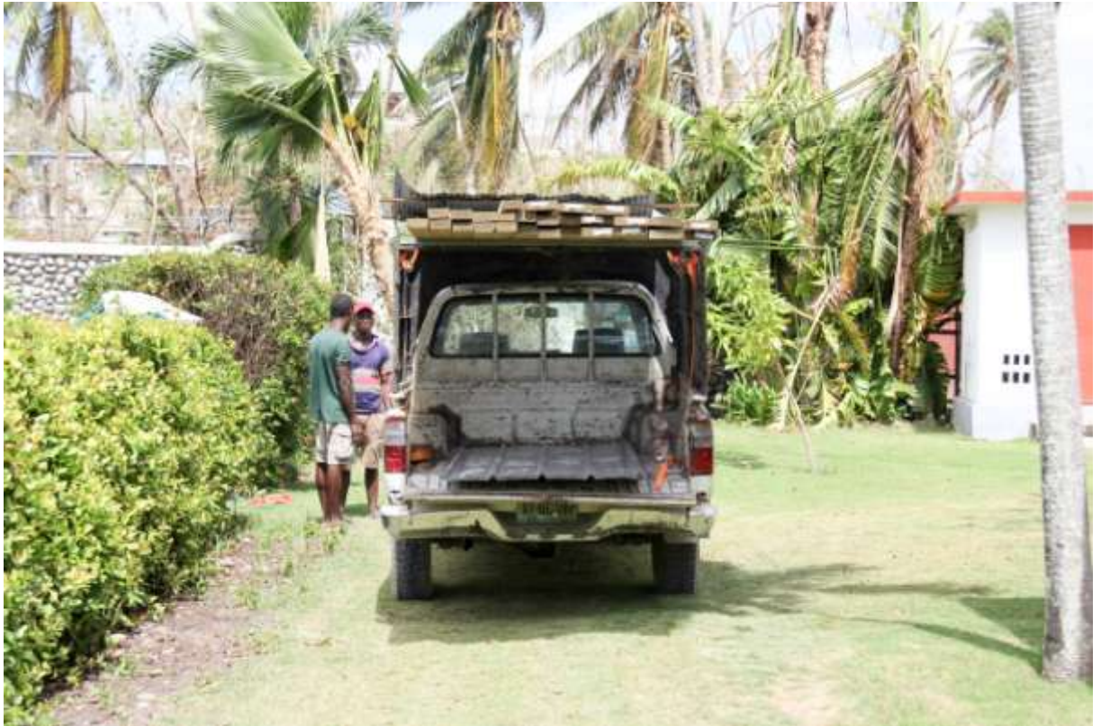
Abbildung 3: Anlieferung von Material für das Dach
